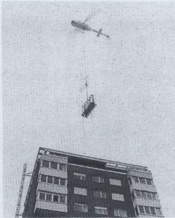
15 Flüge waren nötig, um die Fenster und Schiebetüren zu liefern. Foto: zVg
